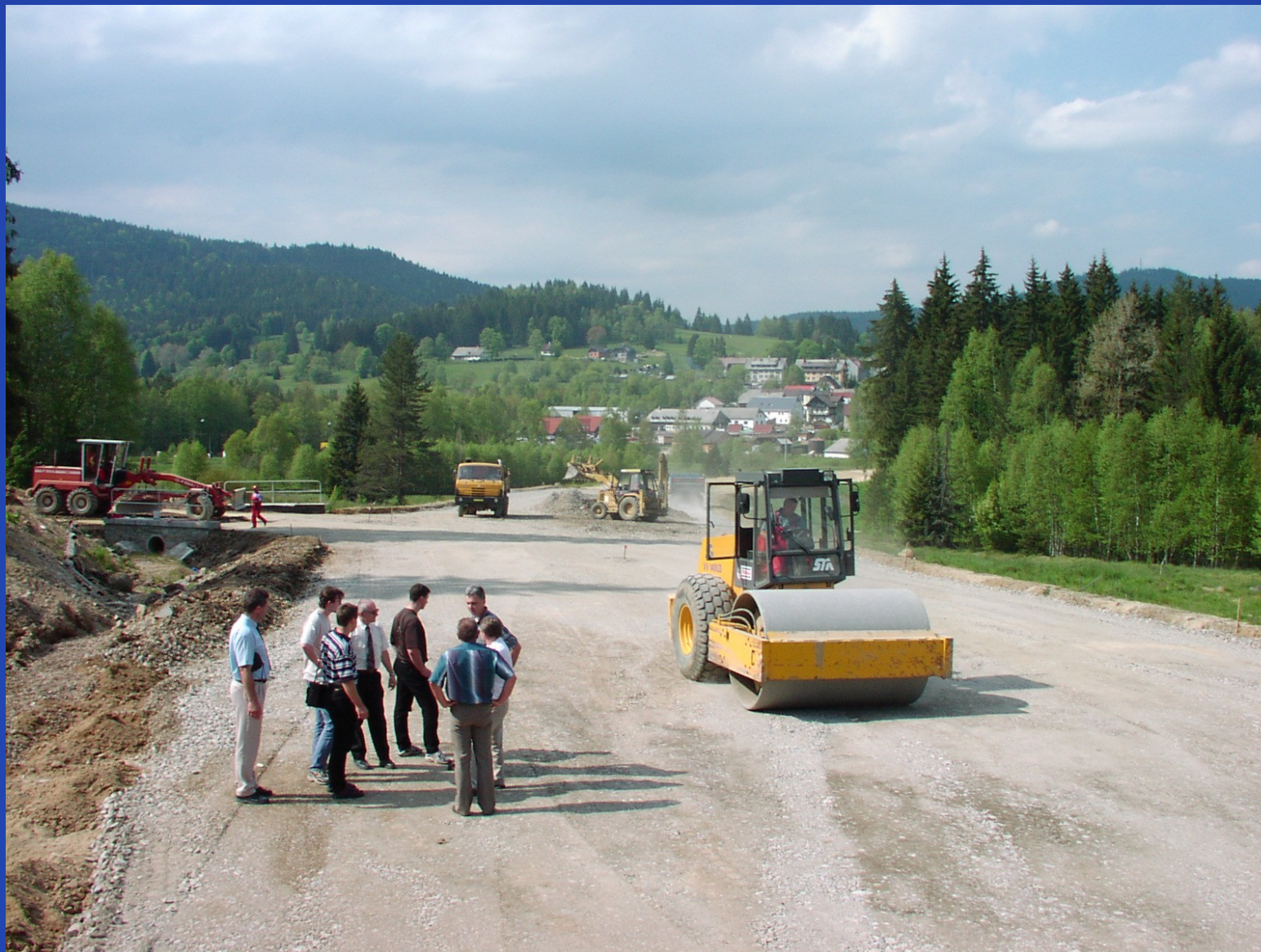
Stav po prvních vrstvách násypu
