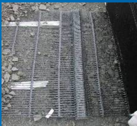
spojka monolitických geomříží
